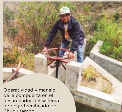
Mantenimiento del sistema de riego tecnificado de Chuquitambo
