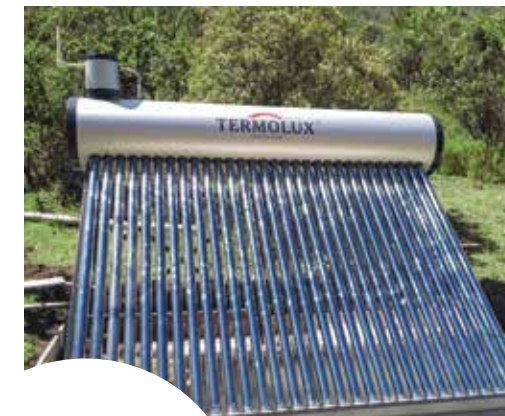
Instalación de termas solares (Quinuapampa)
