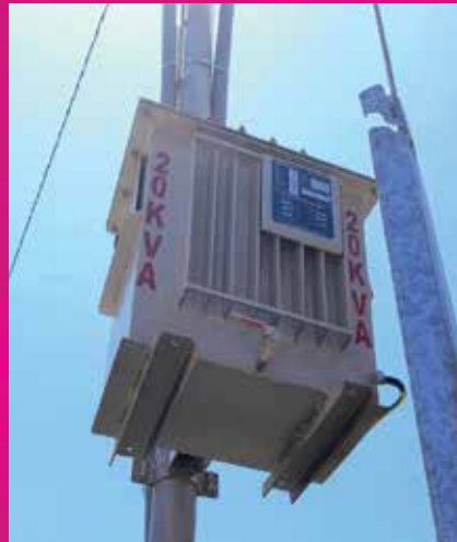
Montaje del transformador
