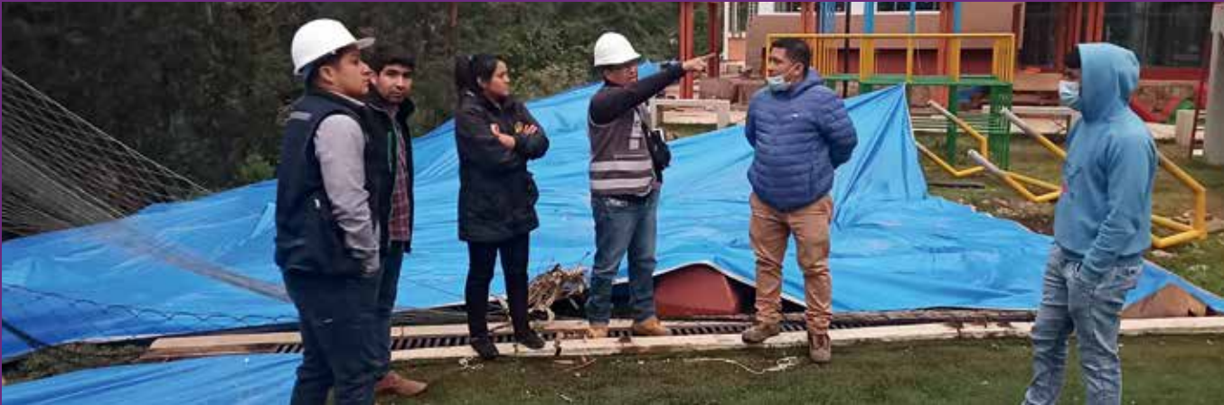
Instalación de rapid cover
