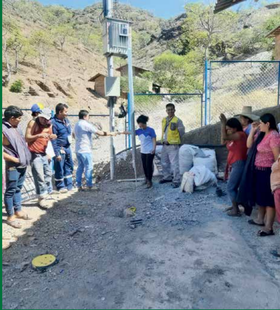
Electrificación de 15 viviendas del sector Huangalé, distrito Sartimbamba.
