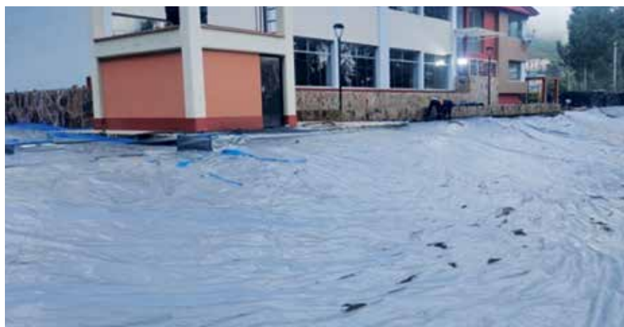
Instalación de Rapid Cover para el control de deslizamiento en taludes en la Biblioteca Gran Pajatén.
