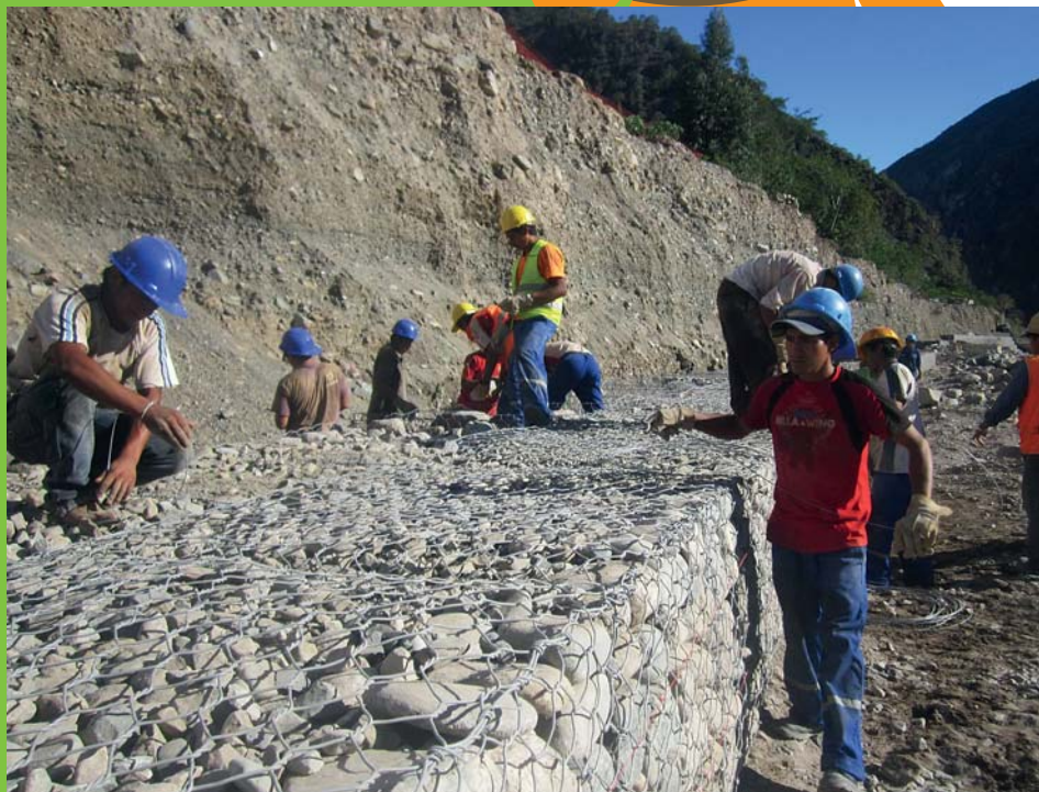
Llenado de gaviones sección 4,5.
