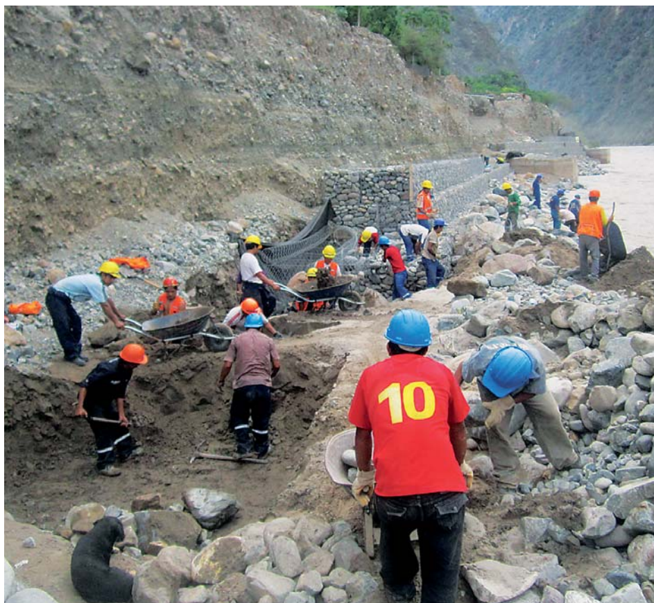
Construcción de muro de gaviones en Chagual.
