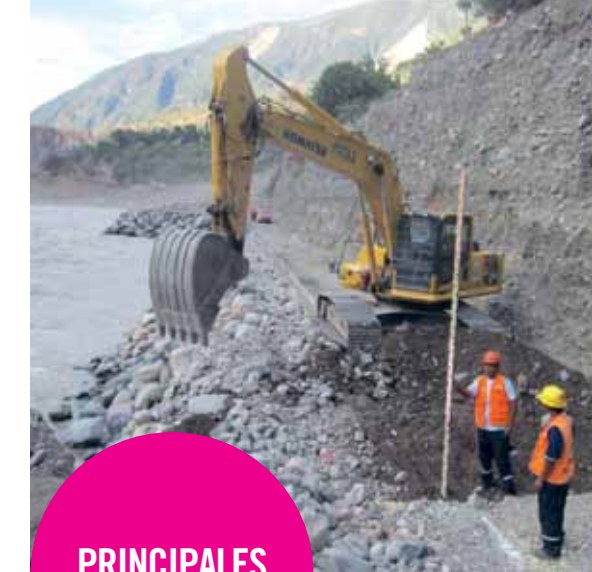
Nivelación de plataforma para construcción de muro de gaviones. Anexo Chagual, distrito de Pataz
