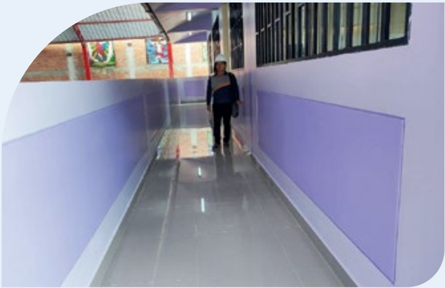
Construcción de aulas en la I.E. N° 80800, anexo Pueblo Nuevo, distrito Pataz
